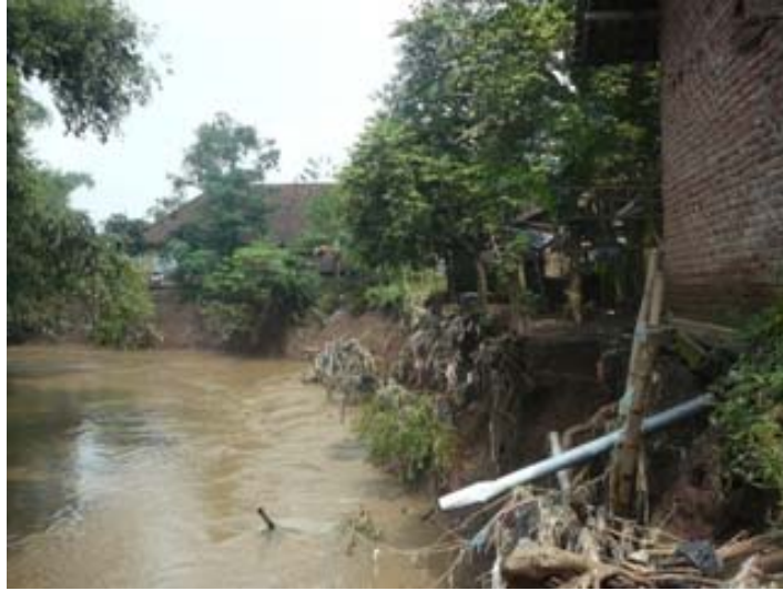
Gambar 6.2 Rumah di Tepi Sungai
