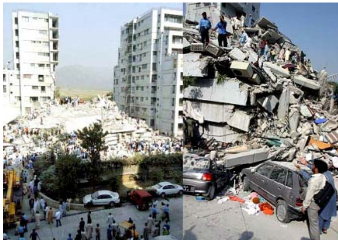
Gambar 9.5 Gedung Beton Luluh Lantak Terkena Gempa Tektonik
