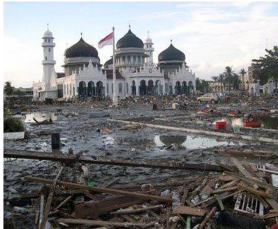
Gambar 9.3 Kerusakan yang disebabkan Tsunami Sumber: http://www.primaironline.com/images_content/20091222tsunami-aceh-2004%20qrz.com-.jpg
